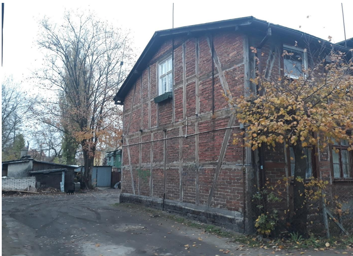
Fotografia 4. Zabytkowa zabudowa mieszkaniowa – w stylu tzw. muru pruskiego, zachodnia część obszaru projektu planu
