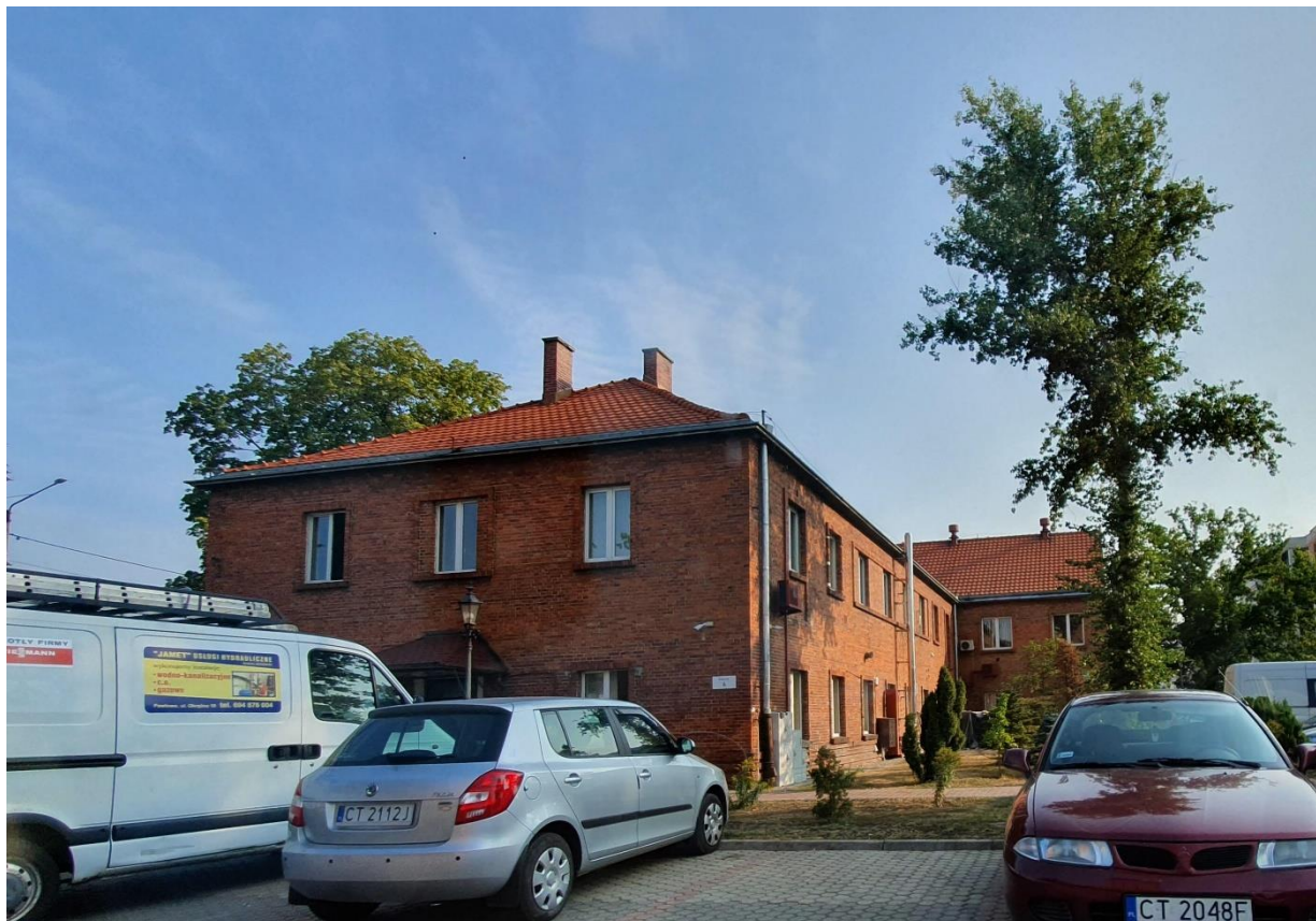
Fot. 3. Jeden z budynków dawnej gazowni miejskiej, wpisany do Gminnej Ewidencji Zabytków (ul. Szosa Lubicka)
