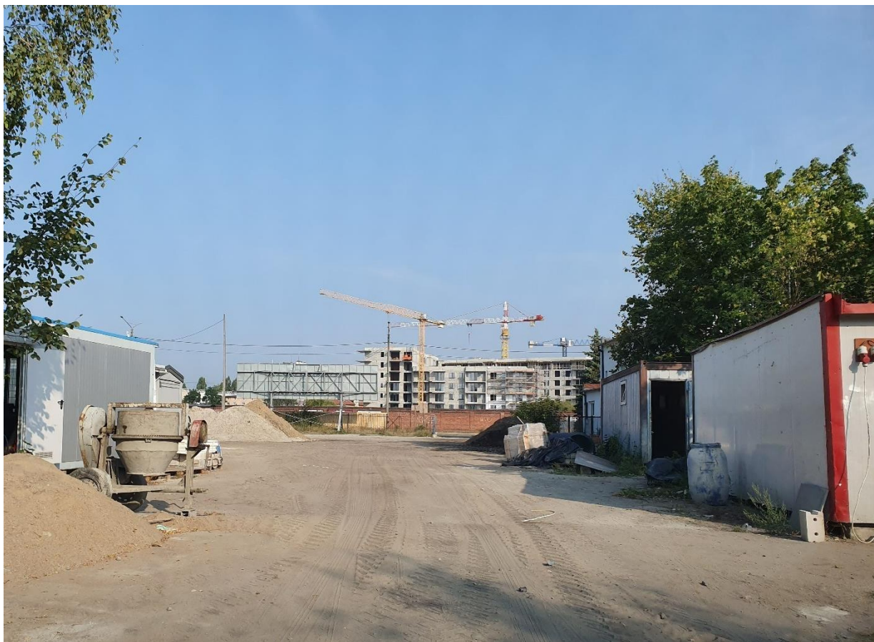
Fot. 1. Plac budowy z drogą dojazdową, w tle widoczna zabudowa mieszkaniowa wielorodzinna w trakcie realizacji (południowo-zachodnia część obszaru objętego projektem planu)
