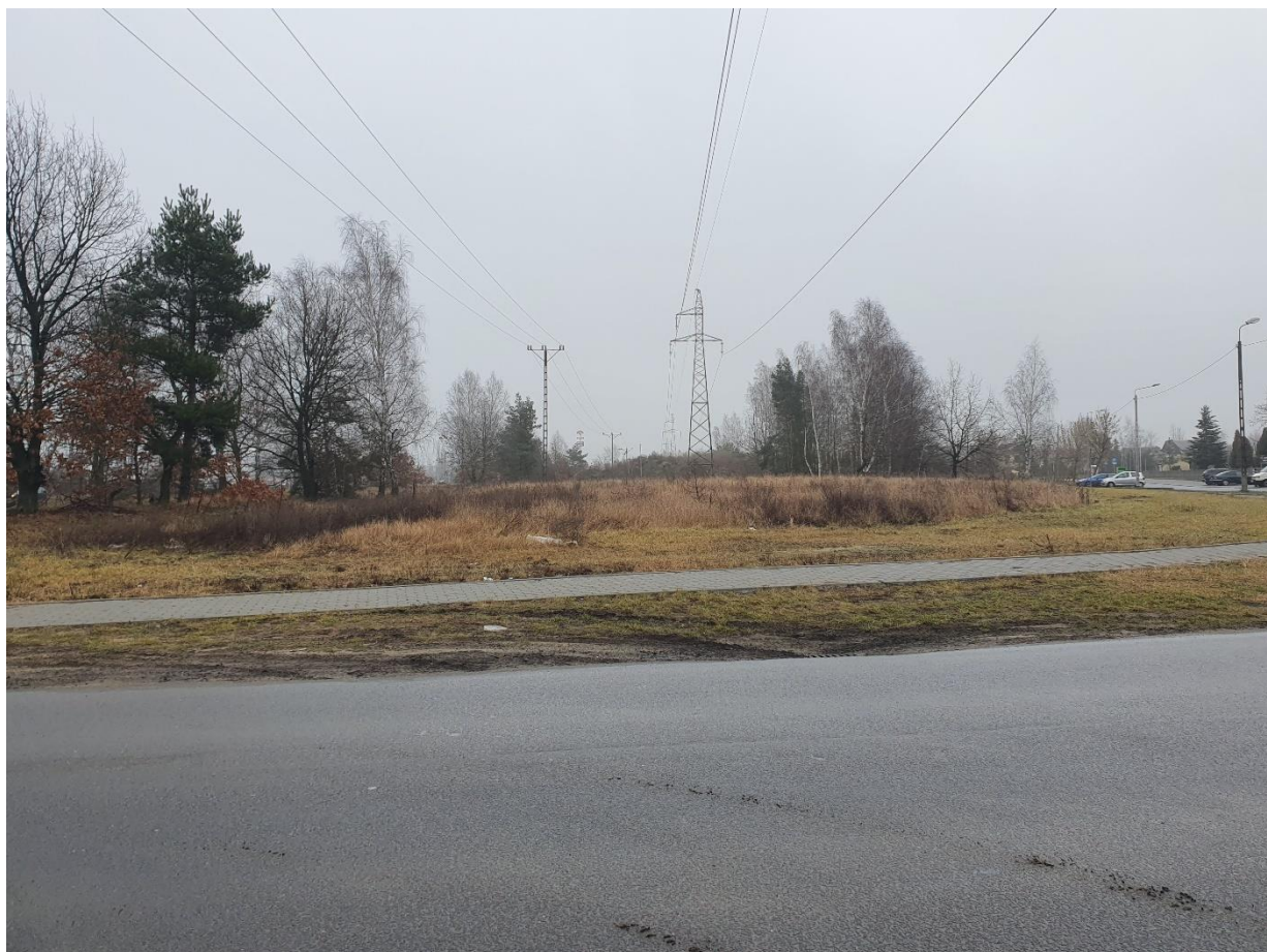
Fot. 2. Linia wysokiego napięcia na terenach między ulicą Łódzką i Włocławską
